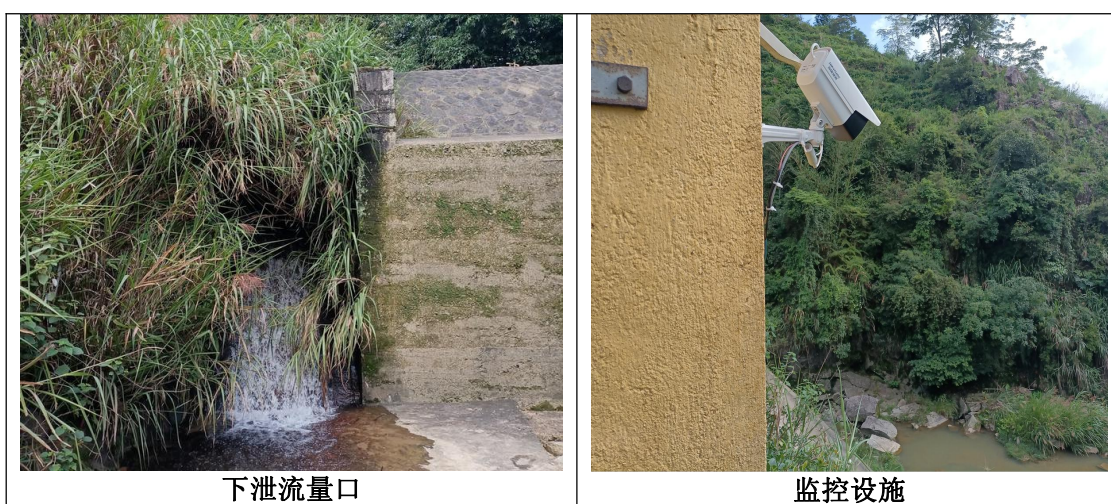
图 5-1 水电站最小生态下泄流量现场照片
